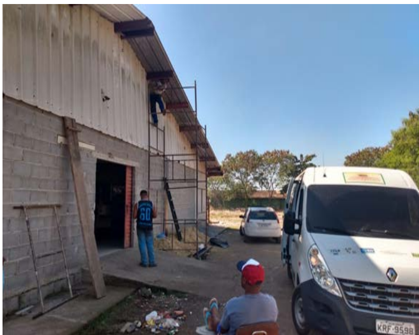
Figura 7 – Galpão da ACAMJG
